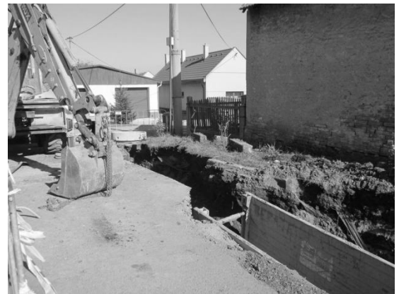
Výstavba kanalizace v ulici Vinohradská; autor: TS
