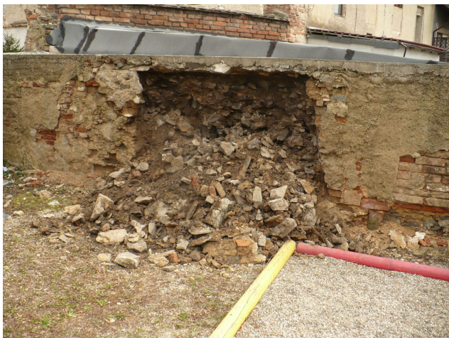
Zed' před rekonstrukcí
