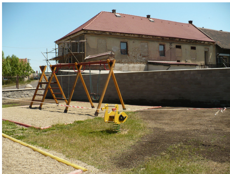
Opravená zeď na dětském hřišti
